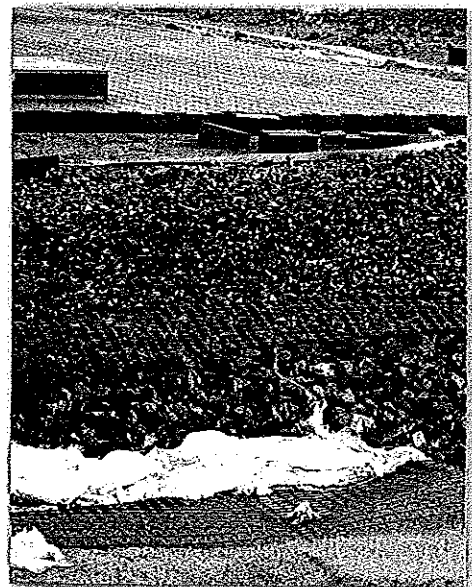
Рис. 3. Дорожная конструкция на контейнерном терминале ОАО «Петролеспорт» (сверху вниз): камни мощения – 100 мм; монтажный (выравнивающий) слой из мелкозернистого песка – 30 мм; геотекстиль; щебень фр. 20-40 с расклинцовкой – 250 мм; георешетка; щебень фр. 40-70-300 мм; георешетка; песок мелкозернистый – 480 мм, геотекстиль
